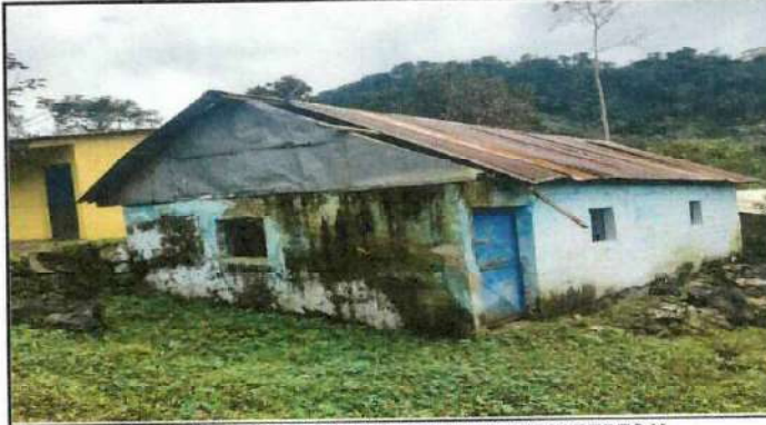
Foto 2: REHABILITACION DE PARED, REPELLO EN PAREDES Y SUSTITUCION DE LAMINAS
