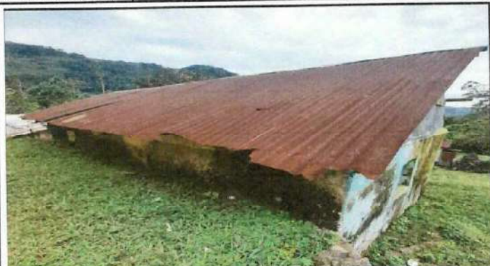
Foto 1: SUSTITUCION DE LAMINAS EN AULAS
