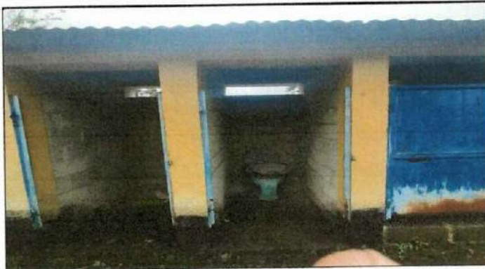
Foto 4: MANTENIMIENTOS DE BAÑOS
