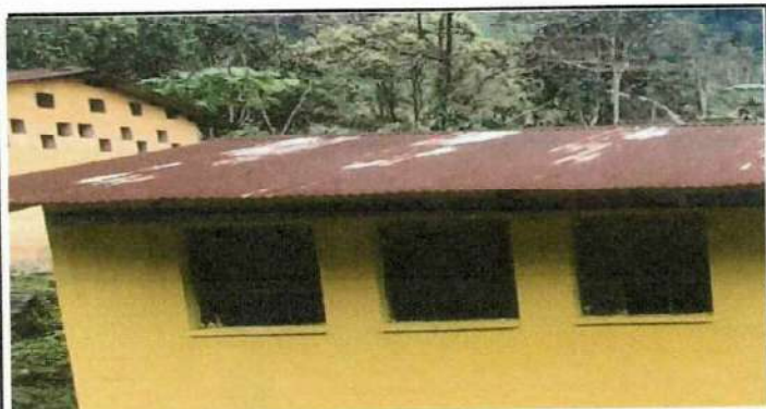
Foto 3: SUSTITUCION DE VENTANAS
